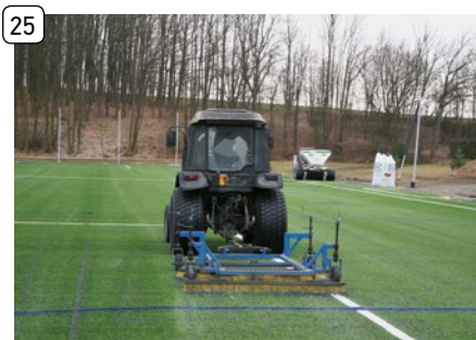
25 Kartáčování po zapravení zásypu - granulát
