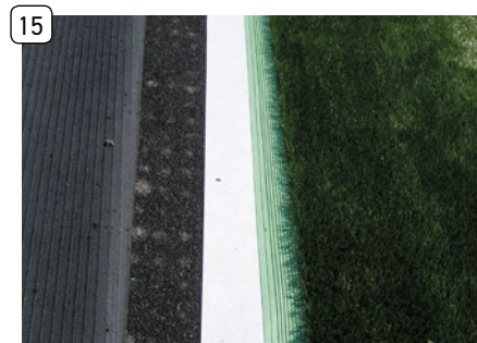
15 Vycentrování pásky s lepidlem a přiklopení UT na lepidlo
