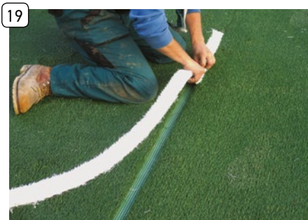
19 Vložení lajny do lepidla
