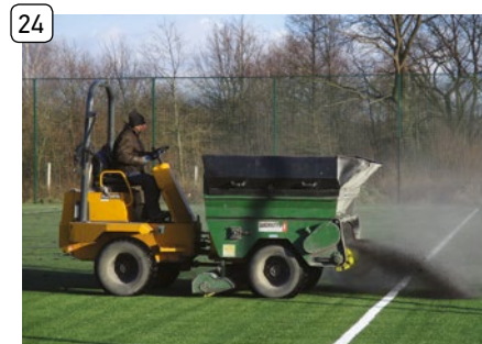
24 Vpravení zásypu do UT - granulát
