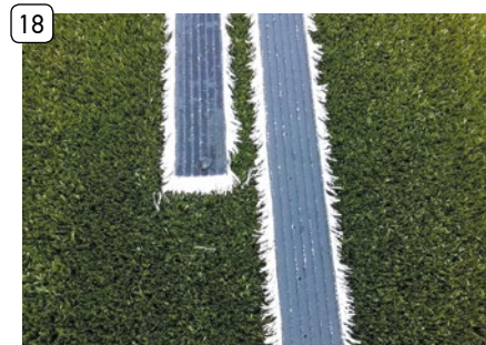
18 Otočení a napnutí lajn - relaxace
