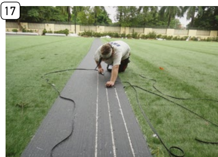
17 Rozřezání lajn, odříznutí části mezi stehy
