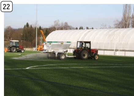
22 Vpravení zásypu do UT - písek
