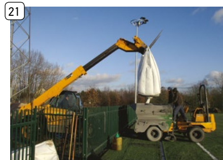
21 Přesun zásypových hmot
